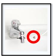
Schieben Sie den weißen Schlauch durch Verschlussmutter in den Osmoseausgang des Perlators. Achten Sie darauf dass der Schlauch bis zum Anschlag gedrückt wird. Dies geht etwas schwer und kann mit einem leichten Hin- und herbewegen erreicht werden.
